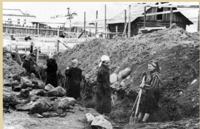
Воскресник сотрудников ЦГА КАССР на строительстве нового здания архива. 1962 г.
